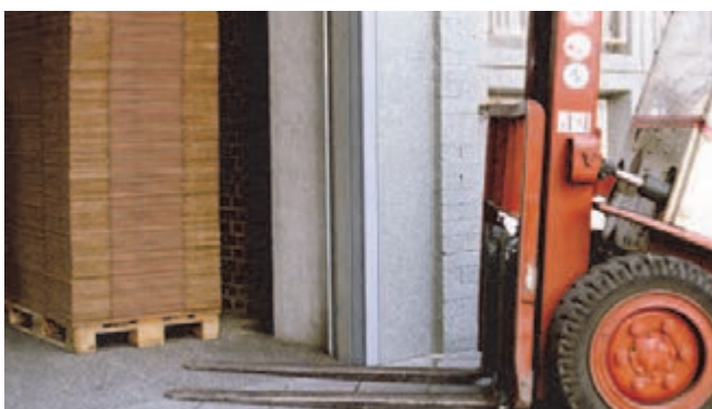
HKW Kantenschutzwinkel an Wandecken in einem Industriegebäude
