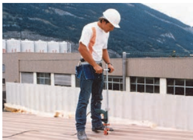
Verschraubung der Stahltrapezbleche mittels Selbstbohrschrauben
