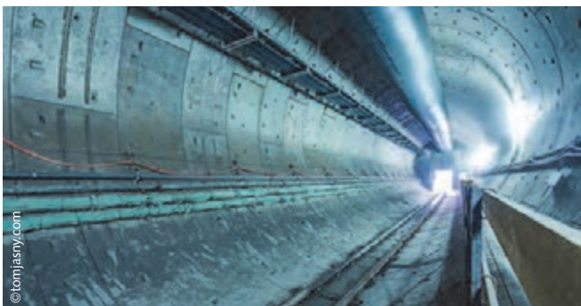
Befestigung von Versorgungsleitungen in TBM-Tunnel mit HTA-CS
