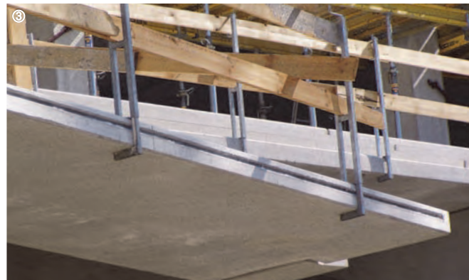
①-④: Befestigung von Geländern, Multifunktionshalle, Berlin
