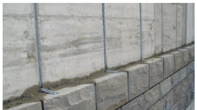
Maueranschluss mit Halben ML
