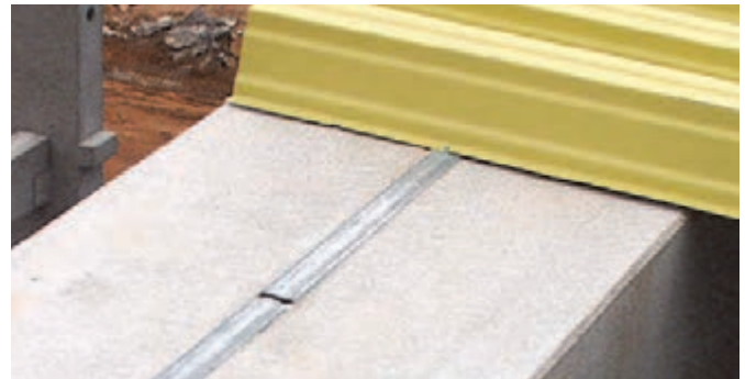
Trapezblechbefestigung im Dachbereich
