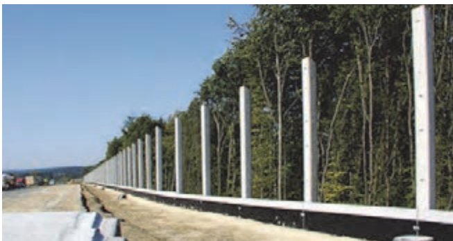
Befestigung von Wand-Elementen an vertikalen Betonstützen
