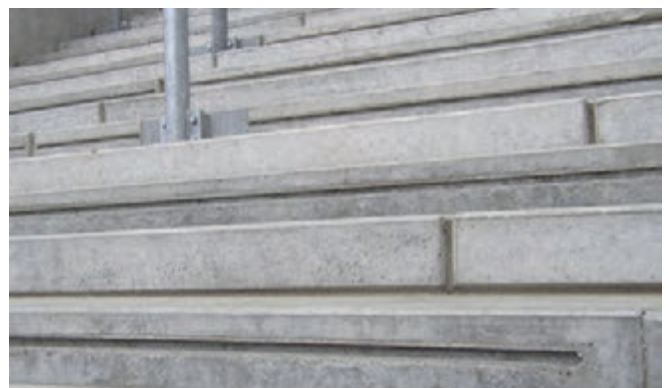
Befestigung Geländer, Stehtribüne Rheinenergiestadion/Köln
