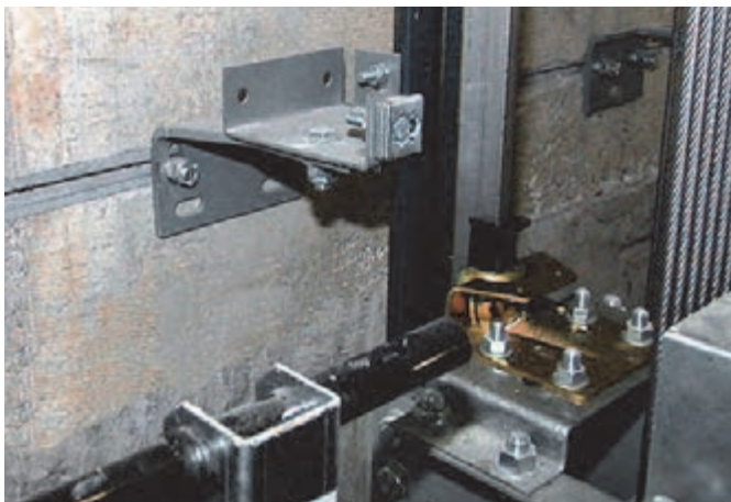
Befestigung von Führungsschienen
