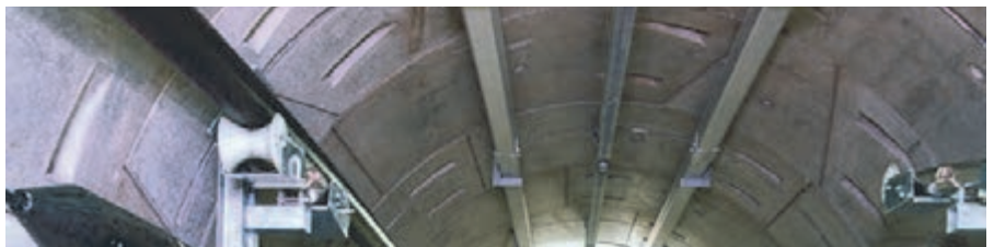
Gebogene Halfenschienen in Tübbing-Elementen
