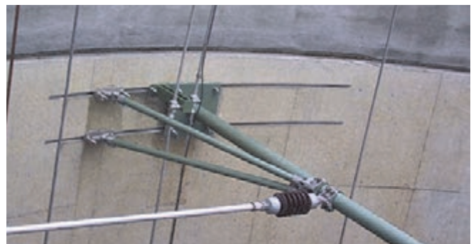
Befestigung von Oberleitungen im Eisenbahntunnel
