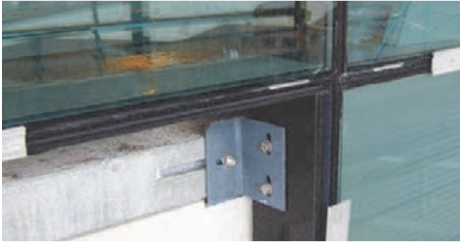
Befestigung einer Curtain-Wall-Fassade
