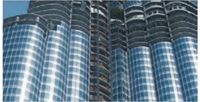
Befestigung einer Curtain-Wall-Fassade
