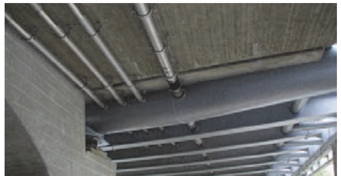
Befestigung von Entwässerungsleitungen
