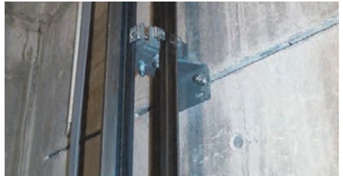
Befestigung einer Führungsschiene im Aufzugbau
