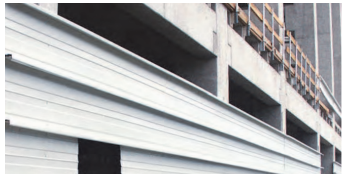
Montierte Wandkassetten am Flughafen Köln/Bonn
