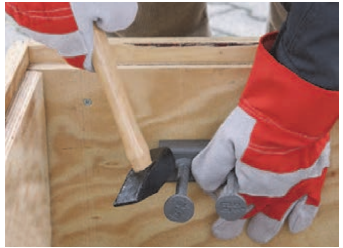
Halfenschienen an die Schalung annageln
