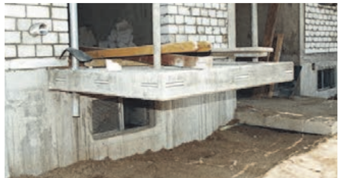
Fertig einbetonierte HGB Schiene, Wohnungsbau
