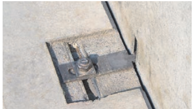
Halben Verankerungslasche HKZ mit gezahnter Gegenplatte
