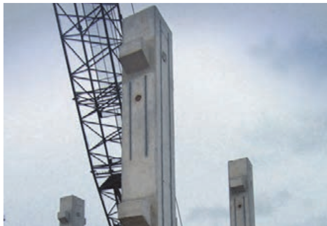
Vertikale Schienen für Anbauteile an Stützen
