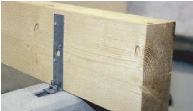
Verbindung von Betonteil und Holzbalken mit HNA
