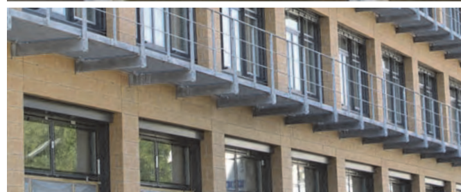
Befestigung von Fluchtwegen/Fluchtbalkenschwert (senkrechte Ausrichtung der Halfenschiene)
