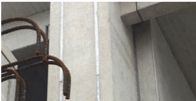
Vertikale Halfen HTU Profilblech-Befestigungsschiene zur Befestigung der Fassadenbekleidung
